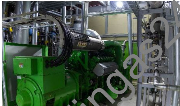
Bioenergie Torsna/CRO 1x 400kWe (1x J412) IB 06/21
