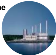
Stromversorger, Kommunen und unabhängige Stromerzeuger
